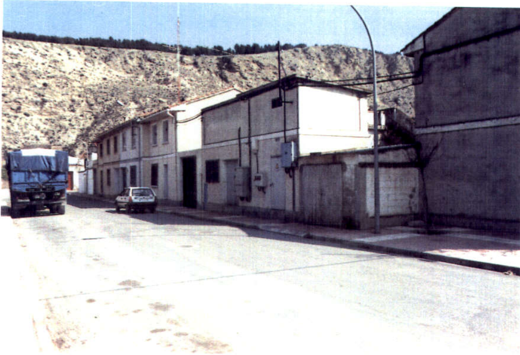
FOTO 1: Vista general de la captación de aguas subterráneas.
